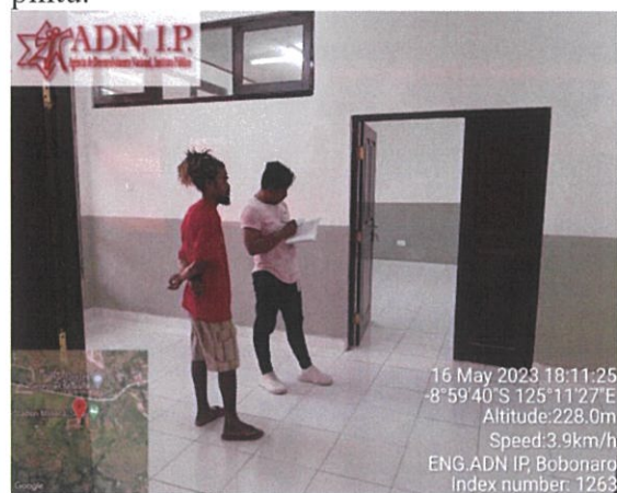
Foto : Servisu pemasangan double daun pintu.
