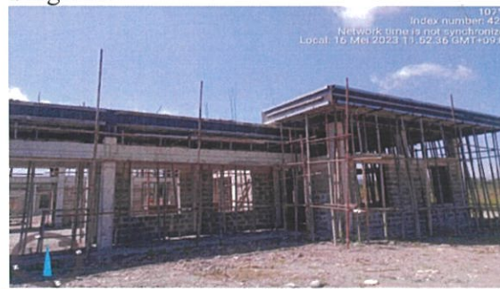
Foto : Servisu monta bekisting ba building Sargento.
