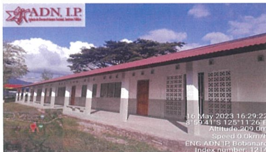
Foto : Servisu pengecetan kolom building RF1
