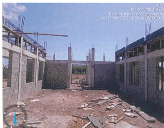
Foto : Servisu monta bekisting ba building soldadu.
