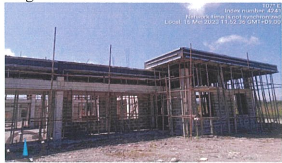
Foto : Servisu monta bekisting ba building Sargento.
