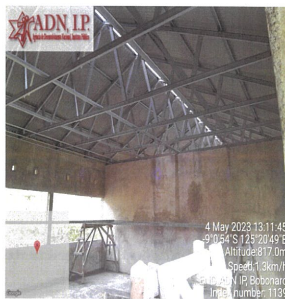
Foto : Servisu pemasangan rangka plafond.
