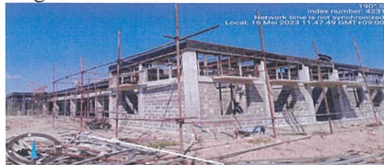
Foto : Servisu monta bekisting ba building Sargento.
