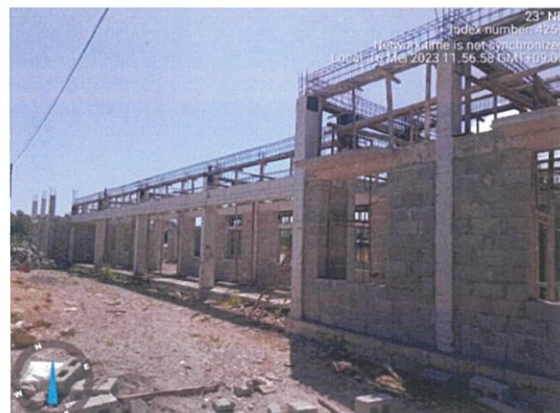
Foto : Servisu monta bekisting ba building soldadu.
