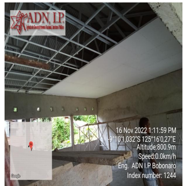
Foto : Servisu rangka plafond nomos plafond triplex ba Building Cdl
