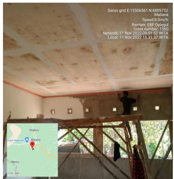
Foto :. Servisu monta rangka plafond inklui mos plafond triplex.
