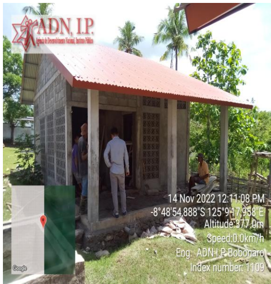
Foto : Servisu plesteran parte interior.
