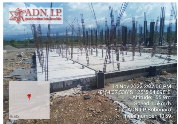
Foto : Penulangan kolom ba Building Dormitorio Soldado.
