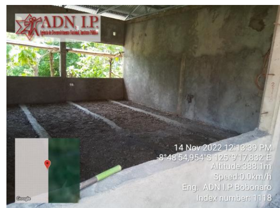
Foto : Halo nivelado ba lantai molok atu cor lantai.
