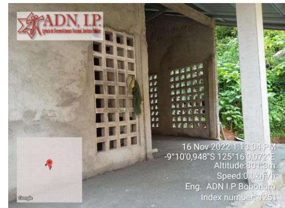
Foto : Servisu plesteran dinding iha parte Toilet.
