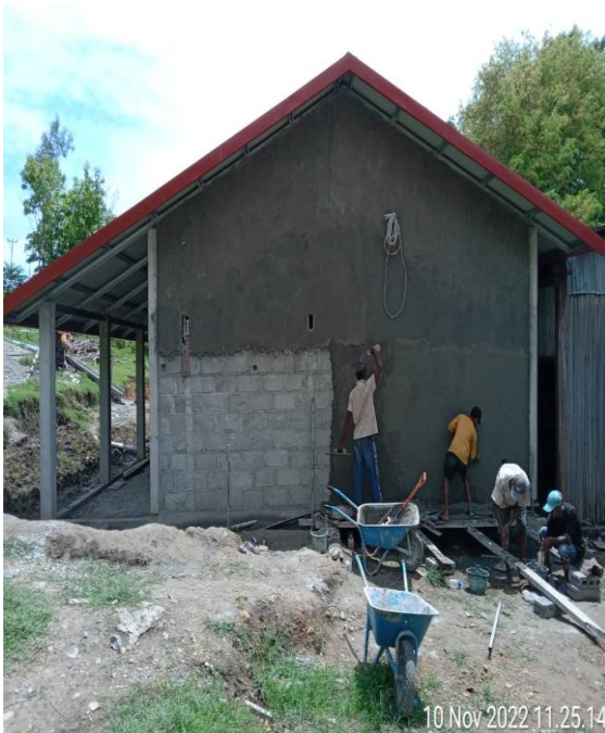
Foto : Servisu plesteran parte liur/ exterior.
