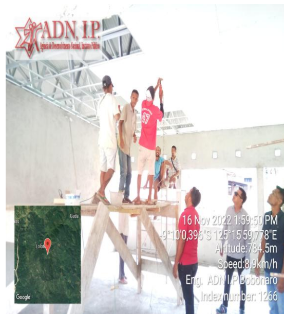
Foto : Servisu rangka plafond nomos plafond triplex ba Building Cdl
