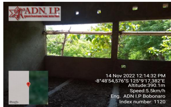
Foto : Halo nivelado ba lantai molok atu cor lantai.
