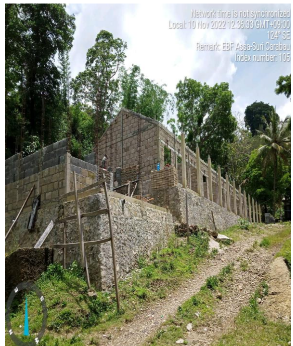
Foto : Servisu monta batako iha area toilet.
