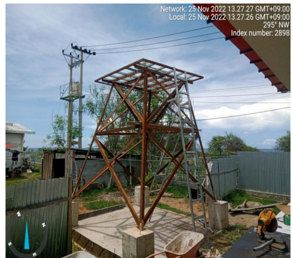
Foto : Monta rangka menara bee.
