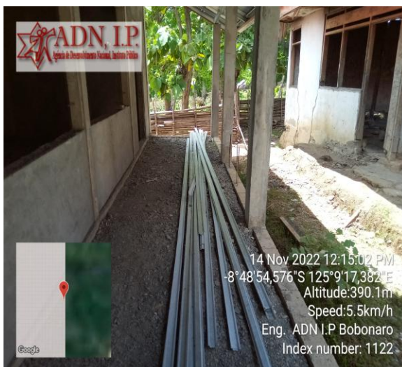
Foto : Material rangka plafond iha ona lokasi projektu.
