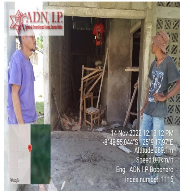
Foto : Servisu plesteran parte interior.
