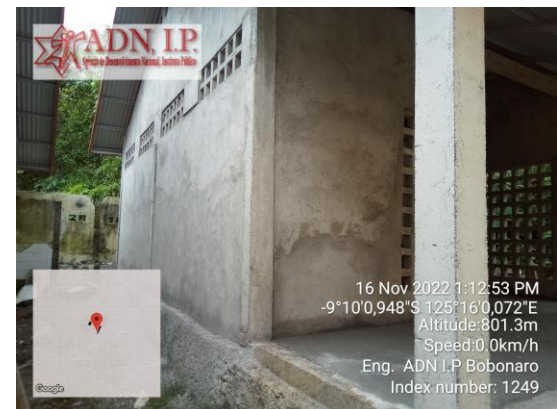
Foto : Servisu plesteran dinding iha parte Toilet.
