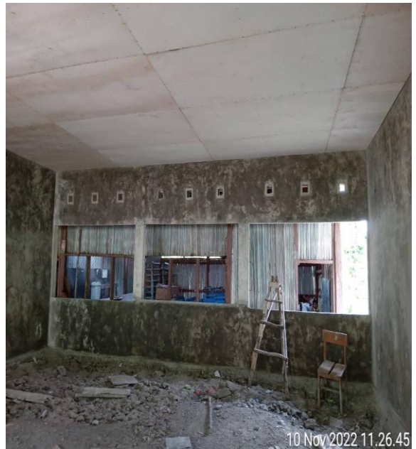
Foto : Servisu monta rangka plafond + plafond
