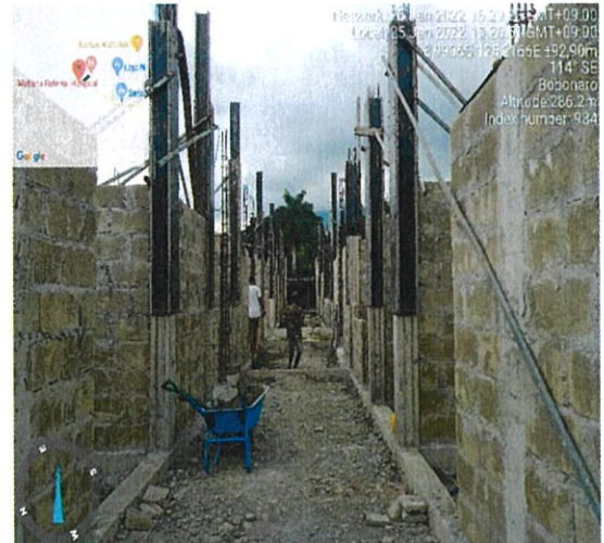
Foto : Pemasangan bekisting servisu kolom
