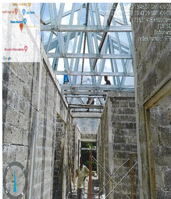
Foto : Pemasangan Kuda – Kuda
