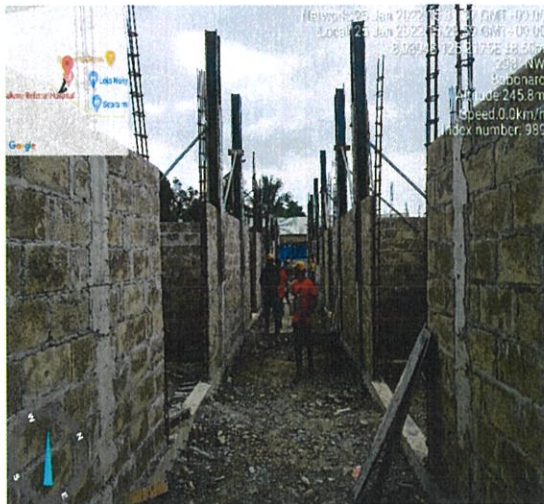
Foto : Pemasangan Bekisting servisu kolom
