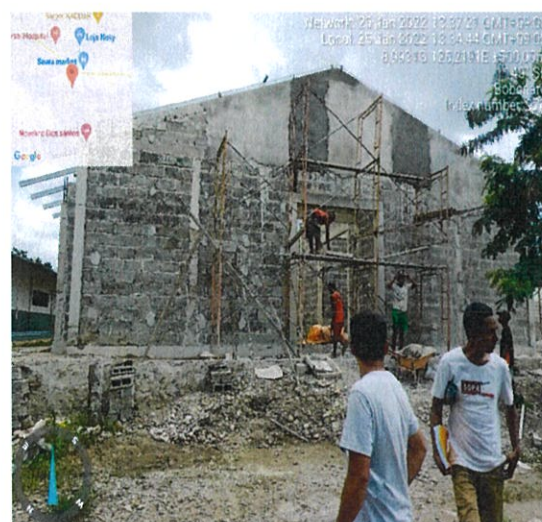
Foto : Servisu plesteran dinding
