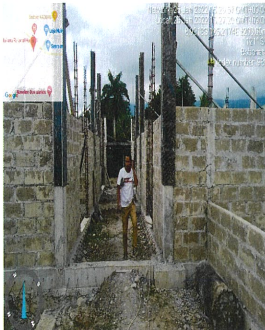
Foto : Servisu pasangan batako.
