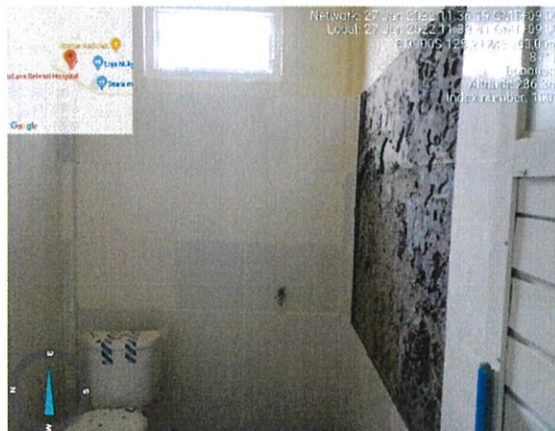
Foto : Pembongkaran dinding toilet.
