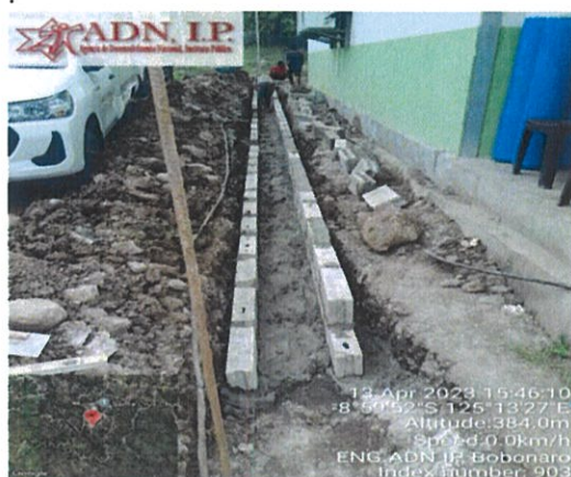
Foto : Servisu Drainage Interen.
