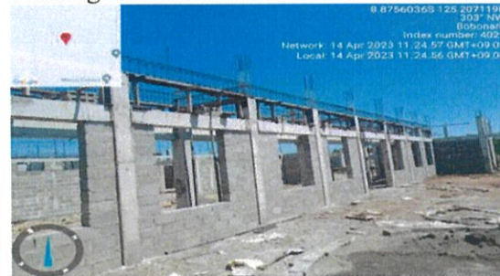
Foto : Servisu penulangan ring balk ba building soldadu.
