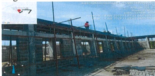
Foto : Servisu monta bekisting ba building Sargento.
