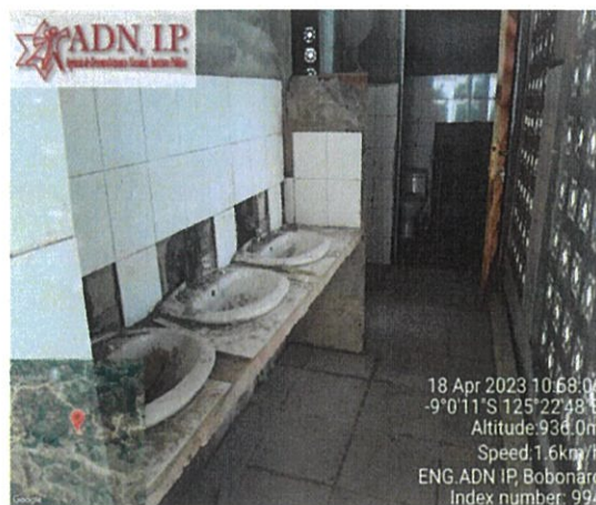
Foto : Servisu Pemasangan keramik dinding 200x200mm building Toilet.
