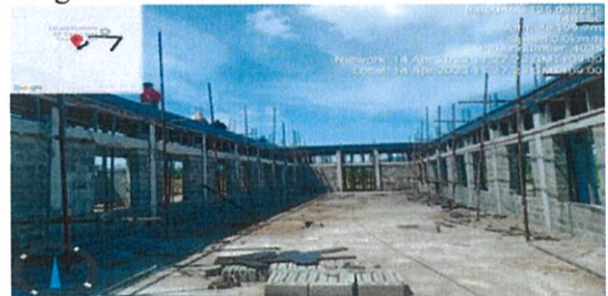
Foto : Servisu monta bekisting ba building Sargento.
