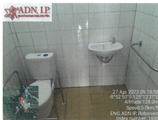
Foto : Servisu pemasangan closet duduk + Assessories
