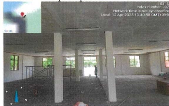
Foto : Servisu pinta plafond.
