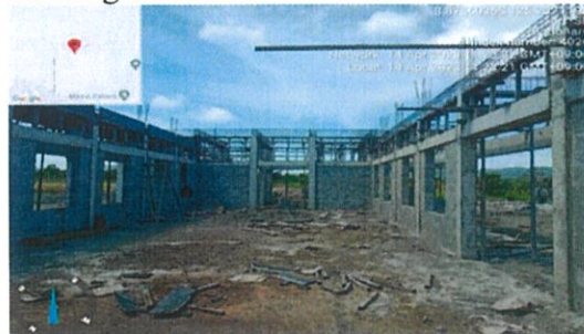
Foto : Servisu penulangan ring balk ba building Soldadu.
