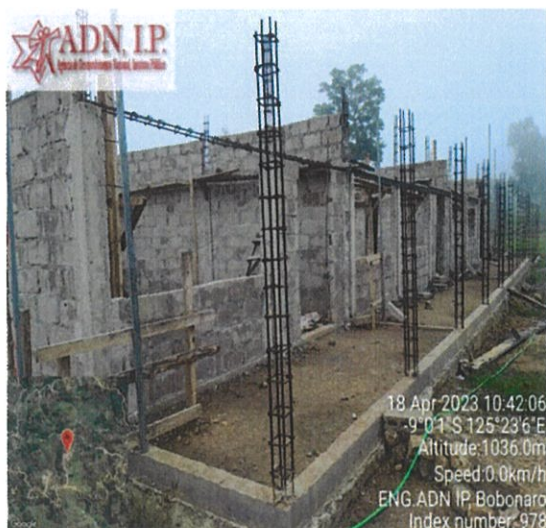
Foto : Servisu pemasangan batako building cdl
