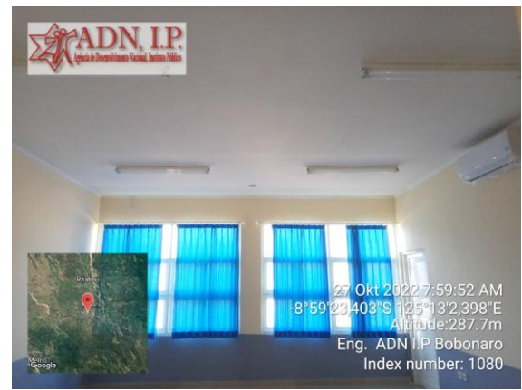
Foto : Supply and install Lighting Phillips F1 TL 2*36 W
