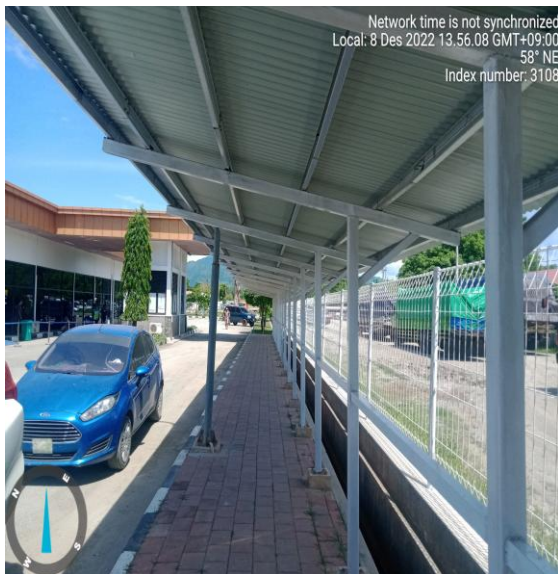
Foto : Rangka kuda – kuda ba kanopi pedestrian shelter posto
