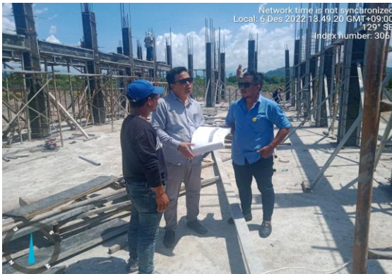
Foto : Servisu monta bekisting ba kolom & balok ba Building Dormitorio Soldado
