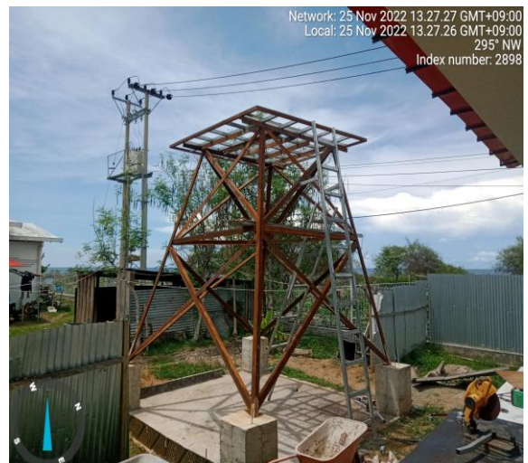
Foto : Monta rangka menara bee.
