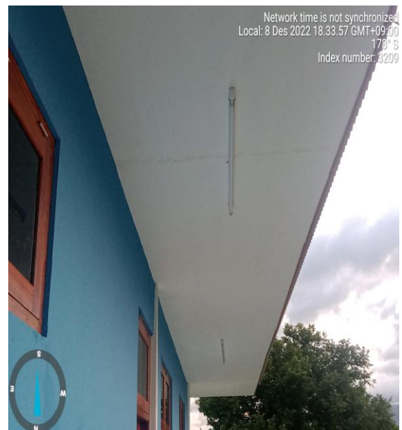
Foto : Servisu lamp. TL 1x36watt
