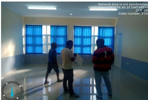
Foto : Supply and install Lighting Phillips F1 TL 2*36 W
