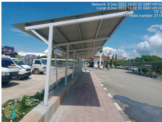
Foto : Pasangan paving block pedestrian shelter posto.
