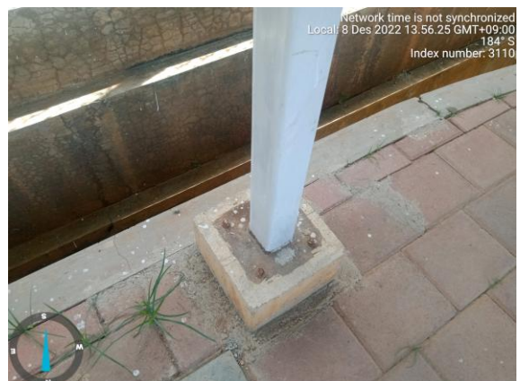
Foto : Pedestal kolom kanopi pedestrian shelter posto
