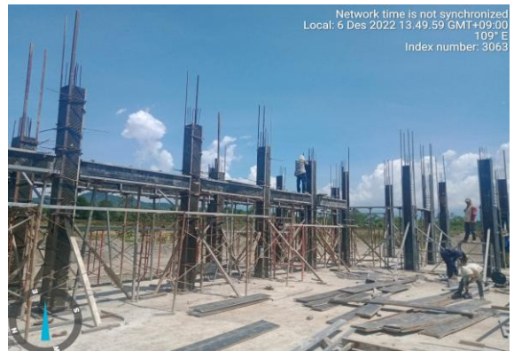
Foto : Penulangan kolom ba Building Dormitorio Soldado.
