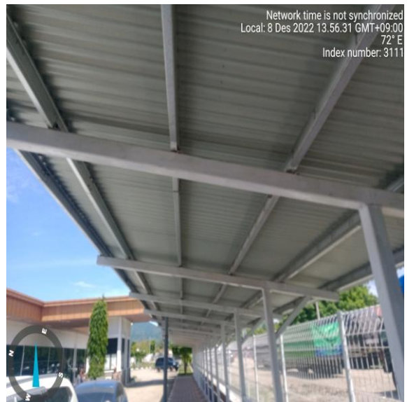
Foto : : Rangka kuda – kuda ba kanopi pedestrian shelter posto
