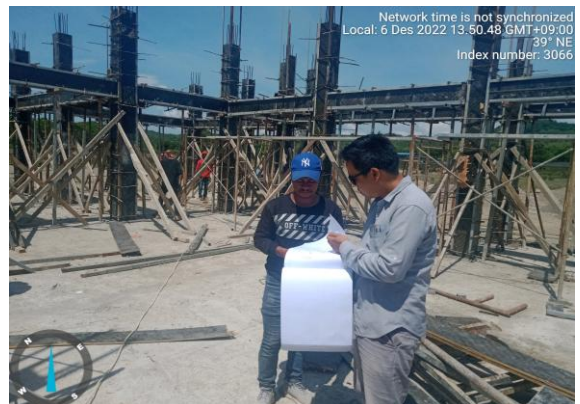
Foto : Penulangan kolom ba Building Dormitorio Soldado.
