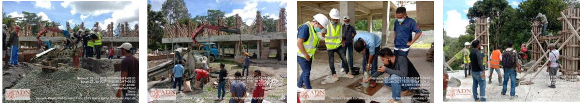
Ermera (22/1) Ekipa Laboratóriu ADN ho Eng. ADN Município Ermera no Eng. Administrasaun Município Ermera Monitoriza no akompanha Prosesu teste Slump Concrete hodi Fui Betaun Ai-rin Lantai 2 nian ba Projetu Konstrusaun Foun Escola Teknik Vokasional iha Gleno Suku Talimoro Postu Ermera, Município Ermera.
