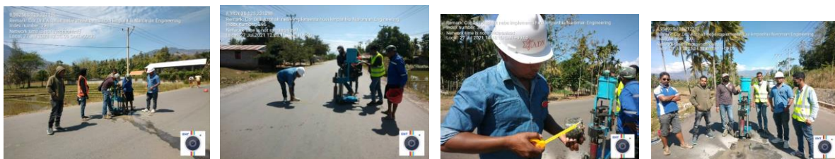
Bobonaro, (27/7) ADN, I.P. Liu husi UCVQ nia Tékniku Ponte no Estrada Munisipiu Bobonaro Eng. Salvador Martins hamutuk ho Ekipa Tékniku Laboratorium ADN halo Core drill Asphalt AC-BC, Tck.6 cm ba Projetu Rehabilitasaun Estrada Maliana.
